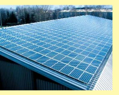
Eine Sporthalle in Dachau: 71 Kilowatt Spitzenleistung aus monokristallinen Solarmodulen.
