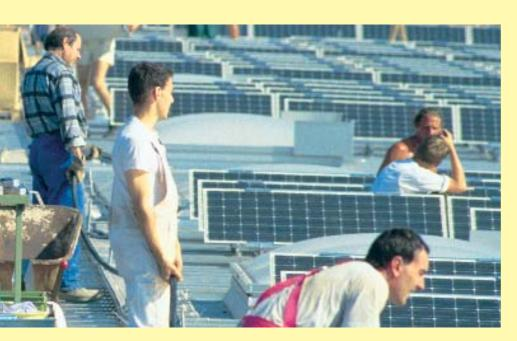
Nur 40 Arbeitstage standen zur Verfügung, um auf sechs Hallendächern Photovoltaikanlagen mit jeweils 176,4 Kilowatt Spitzenleistung zu installieren.
