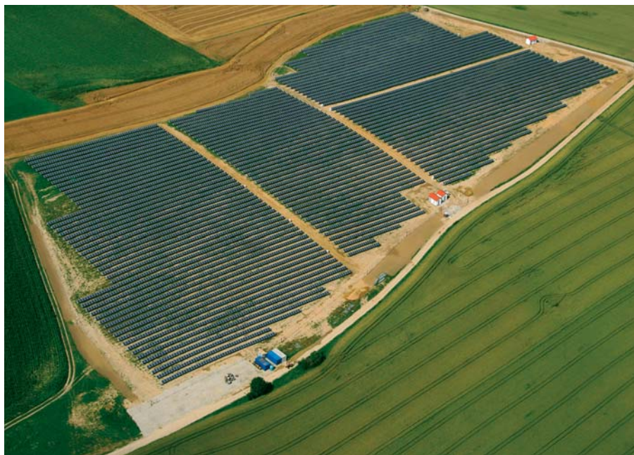
Freiflächenanlage Miegersbach, 1. Bauabschnitt, 2 MW p
